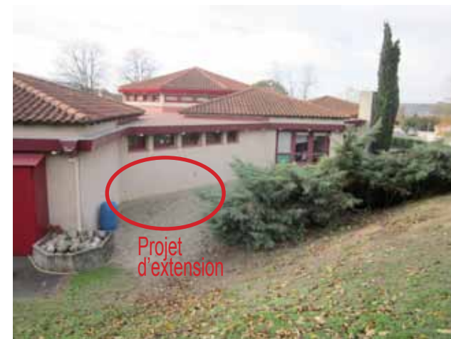
Façade NORD EST école maternelle
